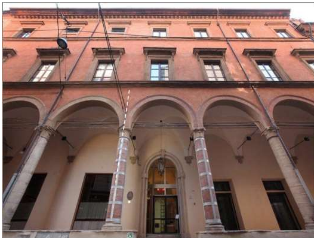
La facciata e il portico di palazzo fava con individuazione degli archi in arenaria e in cotto
