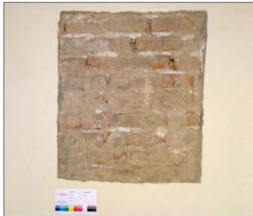
Saggi stratigrafici sulle murature (USM) del piano nobile del palazzo
