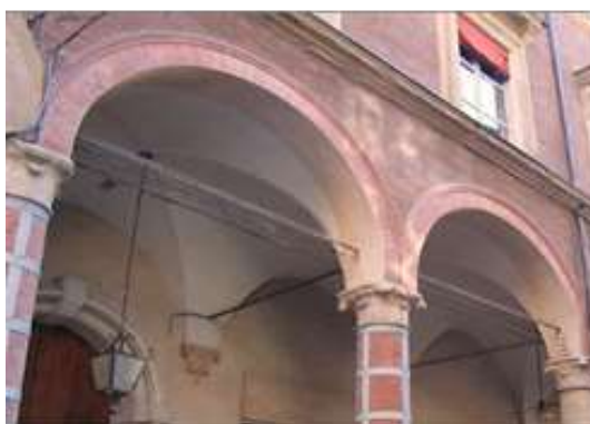
La facciata e il portico di palazzo fava con individuazione degli archi in arenaria e in cotto
