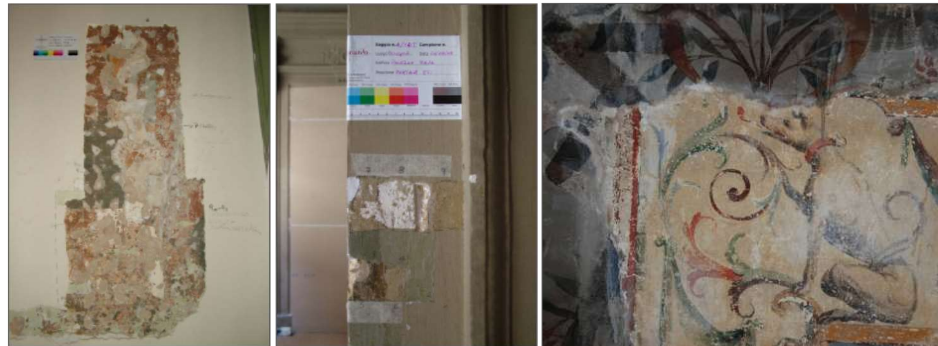
Saggi stratigrafici sui rivestimenti (USR) del piano nobile del palazzo
